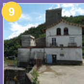
Central elèctrica de Martís a Esponellà
