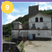
Central elèctrica de Martís a Esponellà
