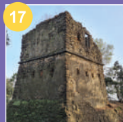
Torre de telegrafia òptica de Can Ginestar
