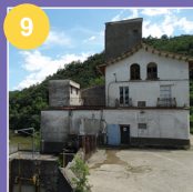
9 Martís power plant, Espotellà
