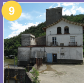
Central elèctrica de Martí a Esponellà
