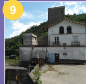
9 Martís power plant, Esponellà
