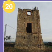
Torre de telegrafia òptica de Fellines de Vilademuls
